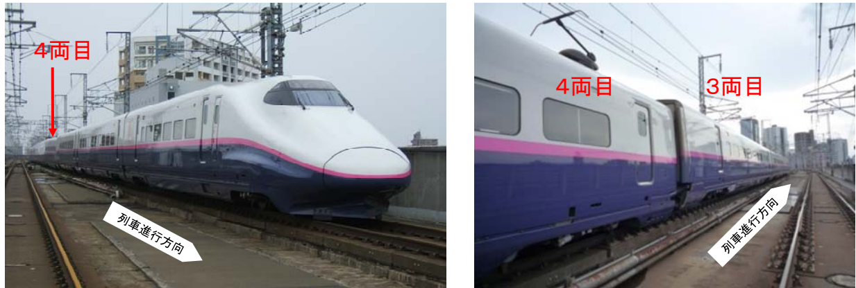
写真1 本件列車の状況
